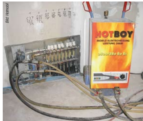
Hotmobil: Funktionsheizten einer Fußbodenheizung mit einem Hotboy.
