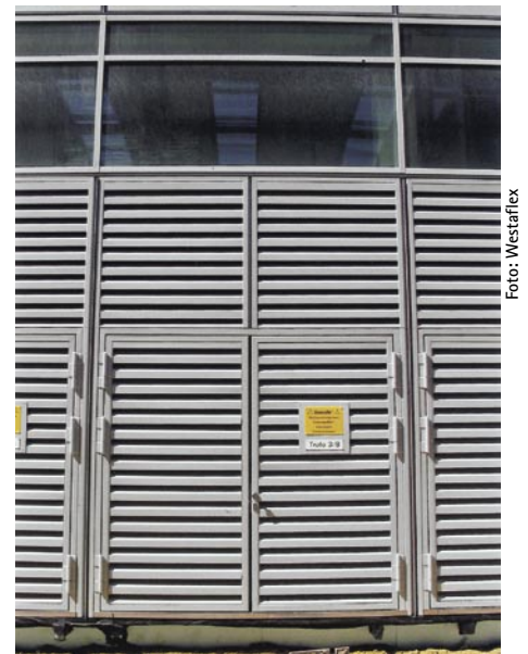
Bild 2 Messehalle in Düsseldorf. Die Ausbildung der Toranlagen mit Lärmschutzelementen berücksichtigt Schalldämpfung und Sabotagesicherheit
