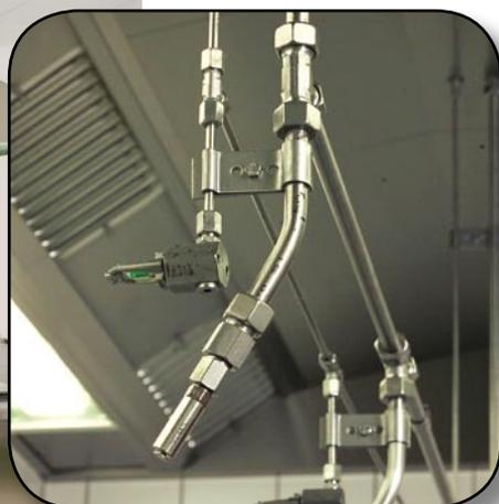
Fritteusen ab 50l Größe brauchen nach der neuen DIN 18869-6 automatische Fettbrand-Löschanlagen. Branderkennungselement und Löschdüse
