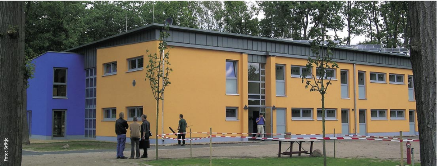
Zweckgebäude des Friesenstadions in Fürstenwalde
