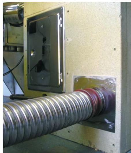
Kritische Punkte bei der raumluftunabhängigen Pellet-Kesseln: Anschlüsse an Brennergebläse, Kessel und Abgassystem
