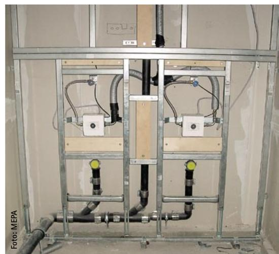
VariTec-Urinalelemente mit vormontierter Urinalspülautomatic Sanicontrol K3
