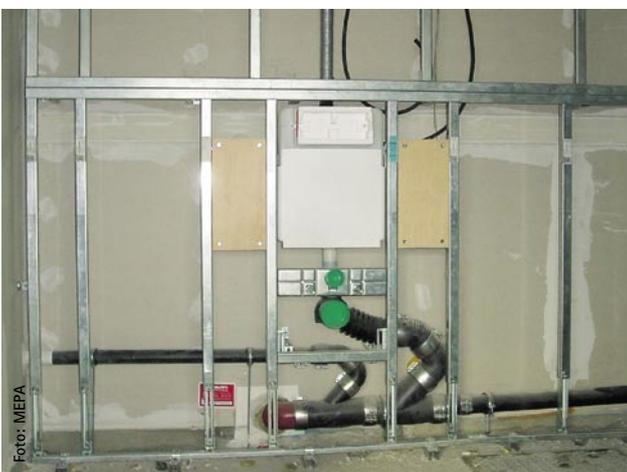
VariTec-Installationselement für ein barrierefreies WC. Die beiden Holzplatten zur Anbringung der Stützklappgriffe wurden bereits werkseitig integriert
