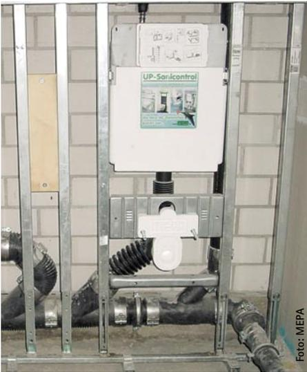
VariVit Step WC-Element mit vormontiertem Sanicontrol-Spülkasten. Durch die verstellbaren Bolzen kann ein Höhenausgleich auch nach der Verfließung vorgenommen werden. Die werkseitig integrierte Holzleiste dient zur Befestigung der Trennwand
