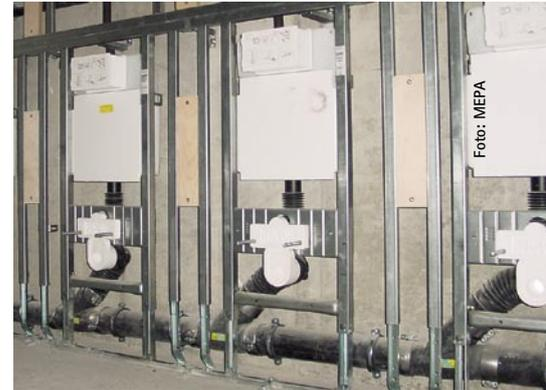
MEPA liefert seine VariTec-Installationswände inkl. Aufsatzelementen komplett vorgefertigt in transportfähigen Modulen. Werkseitig integrierten Holzleisten in den Grund- und Aufsatzelementen sichern die stabile Befestigung der Kabinenwände
