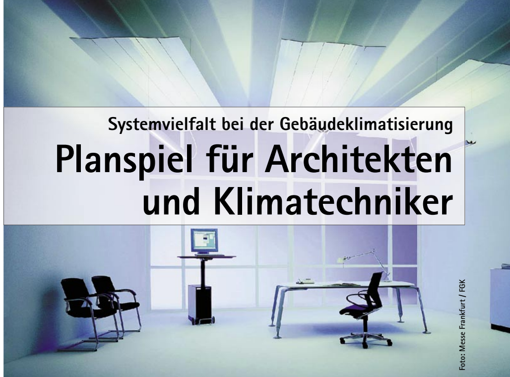
Klimatisierung mit Kühlsegeln
