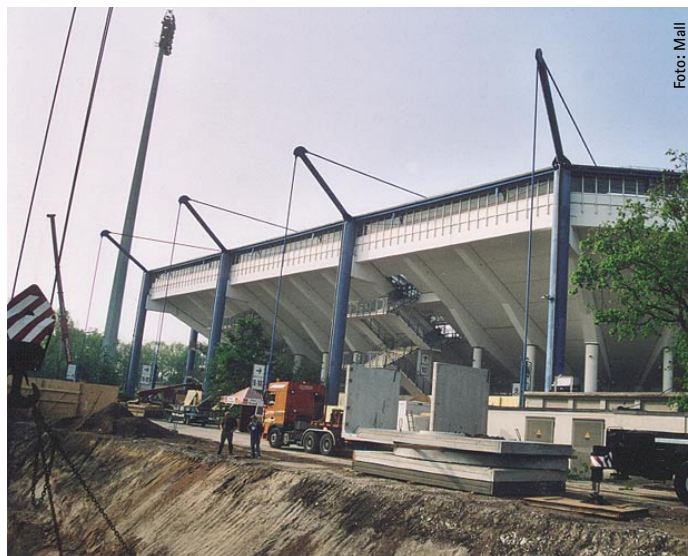
Bild 1 Franken-Stadion Nürnberg nach dem Umbau der Tribünenanlage mit 34 400 m 2 entwässerter Fläche. Im Vordergrund der Aushub für den dreigeteilten Regenspeicher
