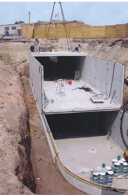
Bild 3 Regenspeicher für das Franken-Stadion. Zwei der drei Zisternen aus Betonfertigteilen werden übereinander angeordnet
