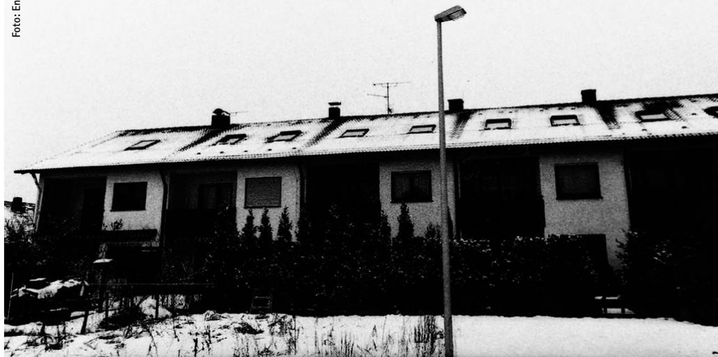
Reihenhaustrennwände – Wärmebrücken sichtbar gemacht
