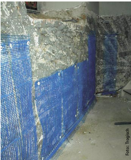
Bild 3 Anordnung der Polymat-Wandheizung im Altarbereich
