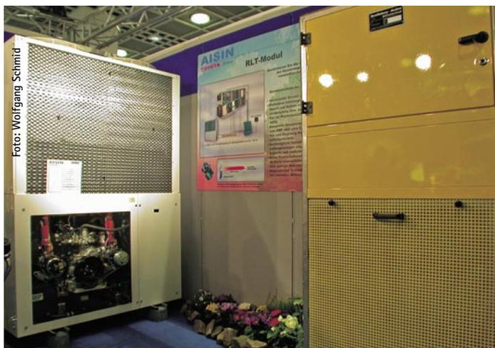
Rund 20 Gasmotor-Wärmepumpen vom Typ Aisin-Toyota sind in Deutschland installiert. Es wird als direktverdampfendes System, mit variablem Kältemittel-Massenstrom und mit einem Hydraulikmodul als Luft-Wasser-System angeboten
