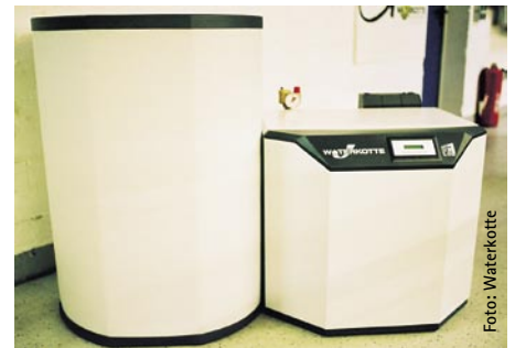
Waterkotte: AI-1 mit 250-l- Warmwasserspeicher
