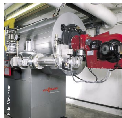
Viessmann: Vitocrossal 300 Gas-Brennwertkessel
