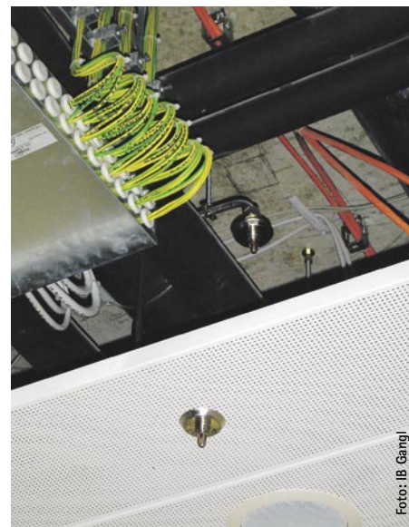
Bild 4 Düsenanordnung im Bereich des Deckenzwischenraums und als Raumschutz im Flur
