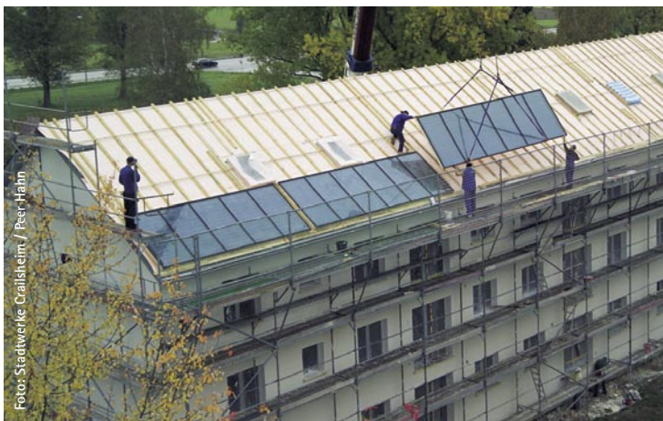
Montage der ersten Kollektoren Ende 2004
