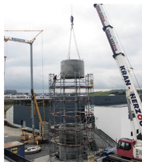
Montage des 100-m 3 -Pufferspeichers aus Betonfertigteilen mit Edelstahlauskleidung
