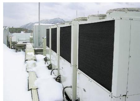
ASUE: Durch die Nutzung der Motorabwärme stellen gasbetriebene Wärmepumpen auch bei niedrigen Außentemperaturen eine hohe Heizleistung zur Verfügung
