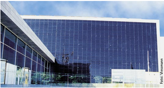
Bild 3 Solar gekühlte Giebelwandbebauung im Neubau des Bundespresseamtes
