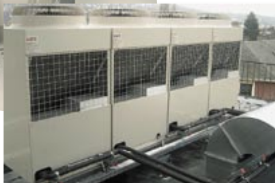
Serverraum mit Präzisionsklimaschrank, Aufstellung der Außeneinheiten
