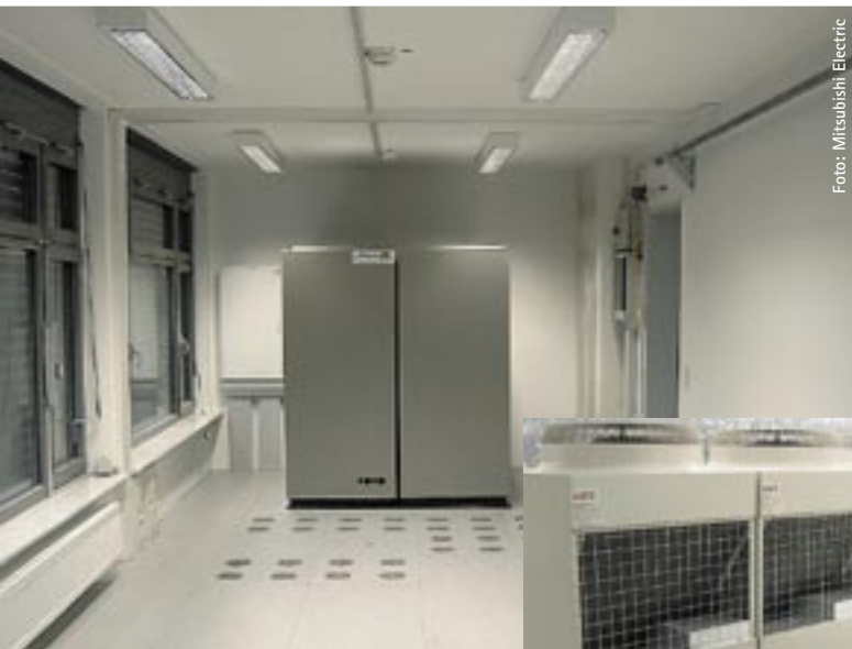
Serverraum mit Präzisionsklimaschrank, Aufstellung der Außeneinheiten
