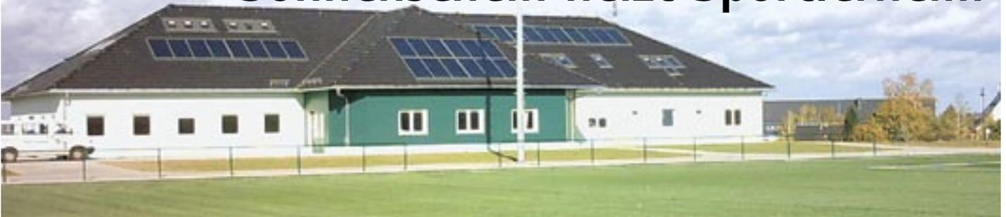
In nur fünf Stunden wurden die vorgefertigten Kollektormodule der insgesamt 65 m<sup>2</sup> großen Indachkollektorfläche auf dem neuen Sport- und Freizeitzentrum in Halsbrücke montiert. Jetzt sparen sie jedes Jahr 2200 m<sup>3</sup> Erdgas und entlasten die Umwelt von rund fünf Tonnen CO<sub>2</sub>-Emissionen.
