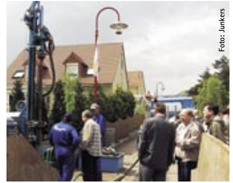
Zum Nachahmen empfohlen: Heizungsbauer Heinz Zieger lud Kunden zu einer Erdsondenbohrung und -installation ein
