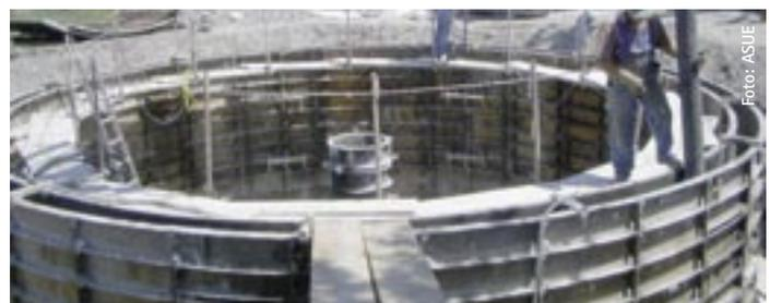
Wird ein Eisspeicher im Winter als Wärmequelle einer Absorptionswärmepumpe genutzt, kann im Sommer das „Abfallprodukt“ Eis den Kühlbedarf decken. Die Lastabführung aus dem Gebäude sowie zusätzliche Solareinträge regenerieren im Sommer den Eisspeicher mit minimalem Primärenergieaufwand **45**
