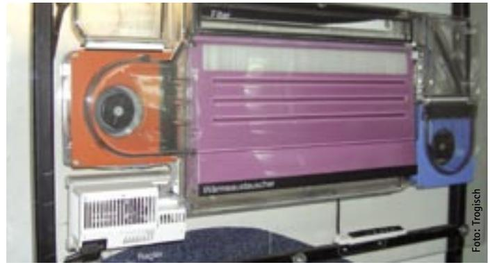
ClimaRad besteht aus einem dezentralen Lüftungsgerät mit Wärmehückgewinnung und einem PWW-Plattenheizkörper. Die Außenluftmenge wird auf Basis der Luftqualität (CO<sub>2</sub> und Feuchte) bedarfsgerecht und somit Energie sparend geregelt **26**
