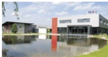
Tece: Das neue Schulungszentrum in Emsdetten
