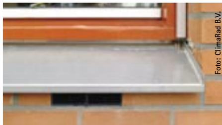
Bild 3 Ansicht eines Außenluftdurchlasses an der Außenwand
