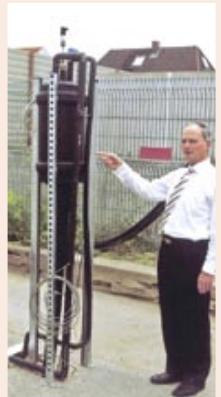
Christian Scholz zeigt den Sondenkopf der Pilot-CO 2 -Erdwärmesondenanlage auf dem Betriebsgrundstück seiner Firma Kaeltro, Berlin
