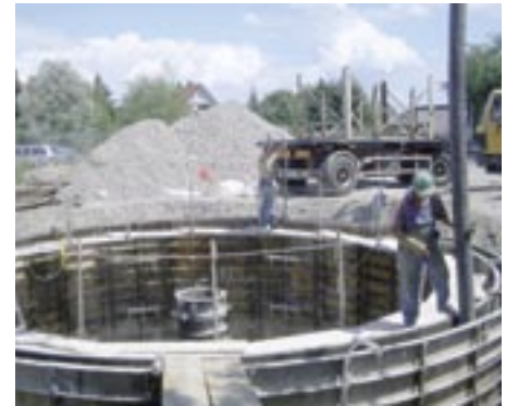
Herstellung eines erdeingebauten Eisspeichers aus Ortbeton
