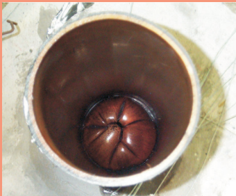
Deckenverschluss nach Brand
