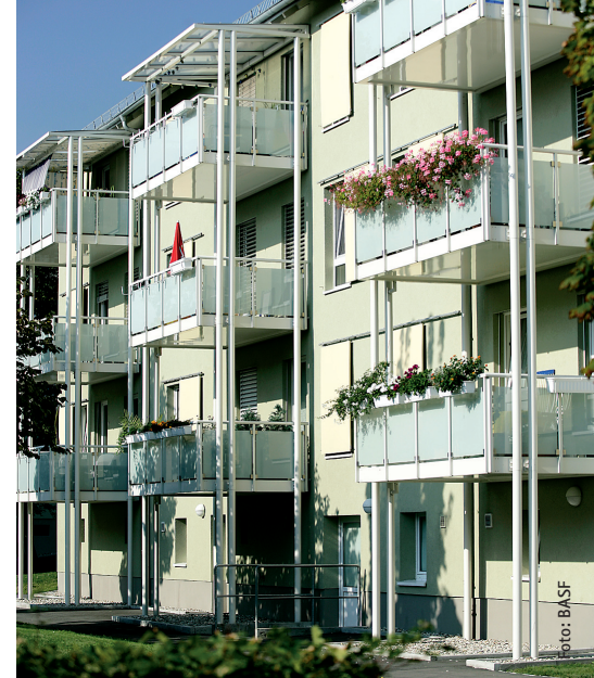
Von außen für den Laien nicht zu erkennen: Rückseite des 3-Liter-Hauses
