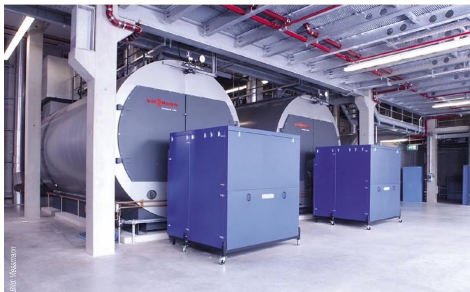
Bild 1 Zwei Hochdruck-Dampferzeuger liefern im Pharmawerk der B. Braun Melsungen AG bis zu 39 t/h Dampf zur Herstellung von Infusionslösungen. [Vitomax 200 HS]
