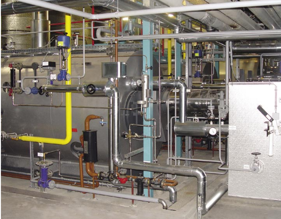
Bild 8 Dampfkessel mit separatem Economiser (rechts). [Vitomax 200 HS]
