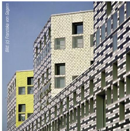
Fassade des AWI. Die Lüftungsflügel der Innenfassade gewährleisten nachts in Kippstellung eine regensichere und einbruchgeschützte Nachtauskühlung.
