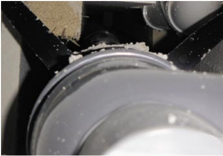
Bild 3 Nicht abnahmefähige Bastellösung (Ansicht von unten durch die Betondecke); Fremdleitungen und brennbare Schachtbaustoffe sind innerhalb eines Schachts für die Abgasleitung nicht zulässig.
