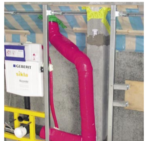
Bild 5 Luftdichte Ableitung am Abgasschacht und an der Entlüftungsleitung
