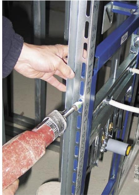
*Schnell montiert: Die selbsttragenden Waschtisch-Elemente des Sanit-Vorwandsystems 995 werden seitlich mit Selbstbohrschrauben am Trockenbau-Profil befestigt.*
