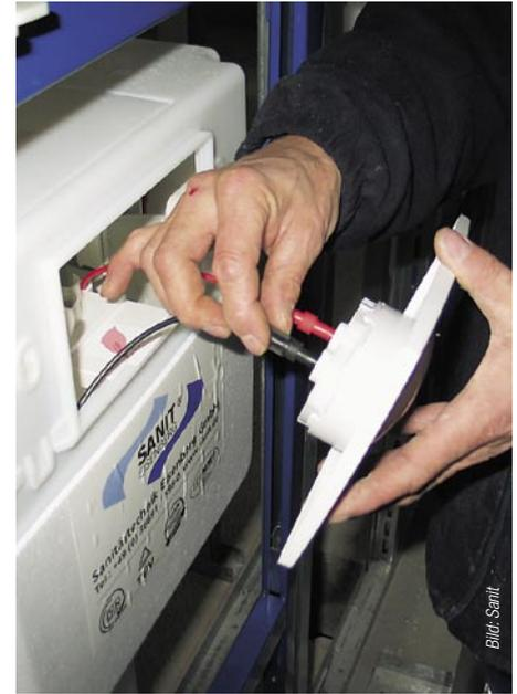
*Ohne Hebel und Wippen kommt die Spültechnik des Sanit-WC-Elements 995 N aus. Die für die Auslösung der Spülung dienenden Kabel werden mittels Bajonettverschluss auf die Betätigungsplatte gesteckt.*
