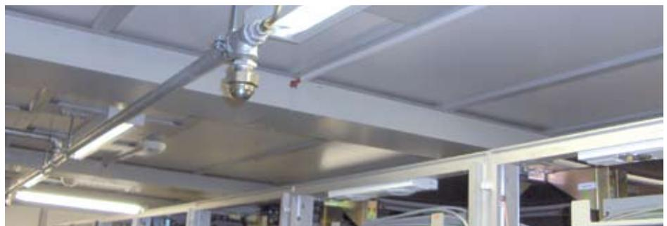
Die Auslegung der Düsen ist bei einer Gaslöschanlage enorm wichtig. Unterschiedlich gestaltete Düsenbohrungen sorgen für eine gleichmäßige Löschmittelverteilung.
