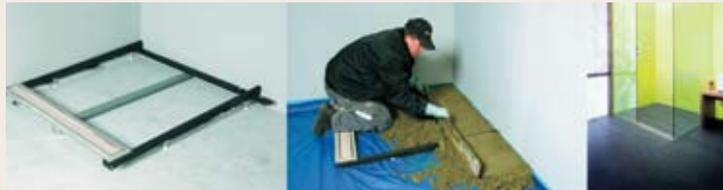
ACO Passavant: Das Bausatzsystem für Showerdrain-Duschrinnen vereinfacht die komplette Ausführung im Sanitärgerwerk.
