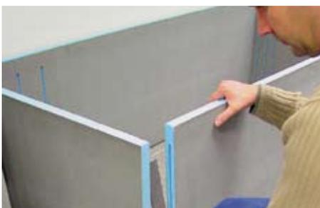
Wedi: Mit der „wedi Bathbox“ wird in wenigen Arbeitsschritten ein direkt verfließbarer Wannenträger erstellt.
