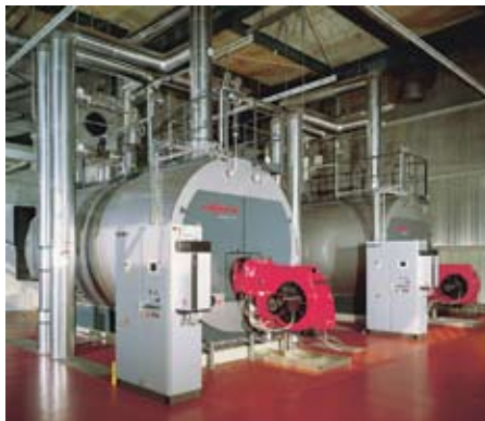
Zweistoffbrenner mit digitalem Feuerungsmanager, O 2 -Regelung und Drehzahlsteuerung an Heißwasserkesseln.
