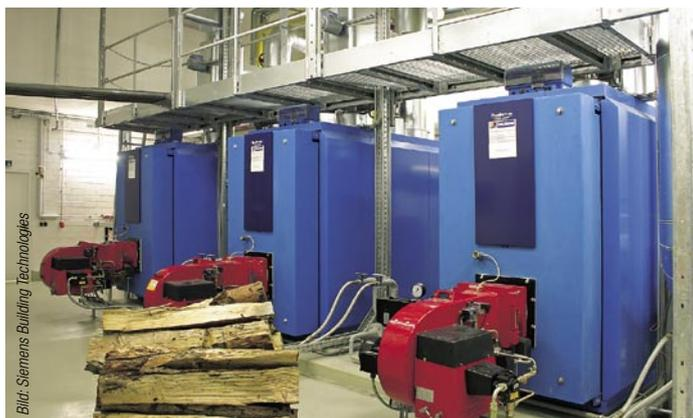
Die Wärmeversorgung ist redundant aufgebaut, Zweistoffbrenner und 60.000 l Heizölbevorratung sorgen für zusätzliche Sicherheit.
