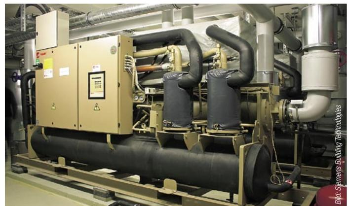
Die Steuerung der Kältemaschine ist direkt über BACnet auf die Gebäudeautomation geschaltet.
