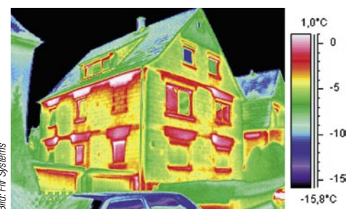
Mit Thermobildern lassen sich energetische Schwachstellen visualisieren und Bauherren sensibilisieren.
