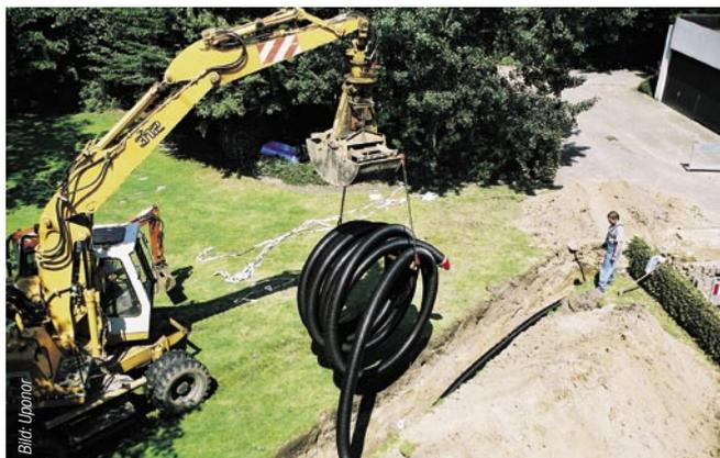
*Die Verlegung erfolgte von der auf die Baustelle gelieferten Großrolle direkt in den Graben.*
