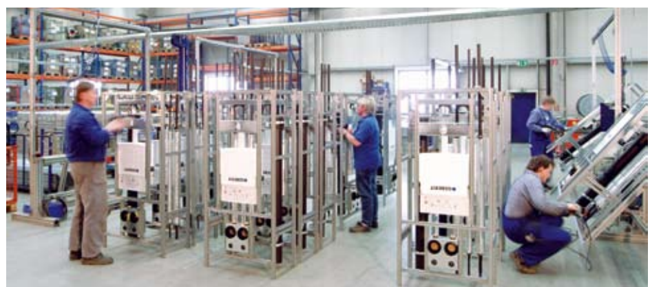
Vorfertigung bei Geberit in Lichtenstein/Sachsen: Komplett Sanitärelemente pünktlich auf der Baustelle.
