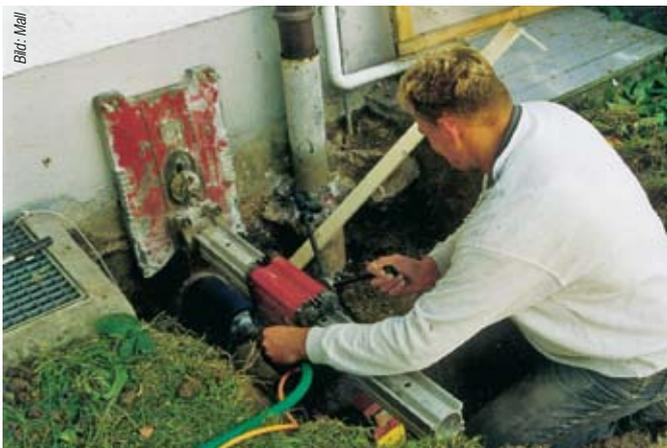
*Außenwanddurchführung bei Modernisierung, Kernbohrung für Regenwasser und Elektroleitung. Der Dichtungseinsatz wird häufig als Teil der kompletten Anlagentechnik mitgeliefert.*
