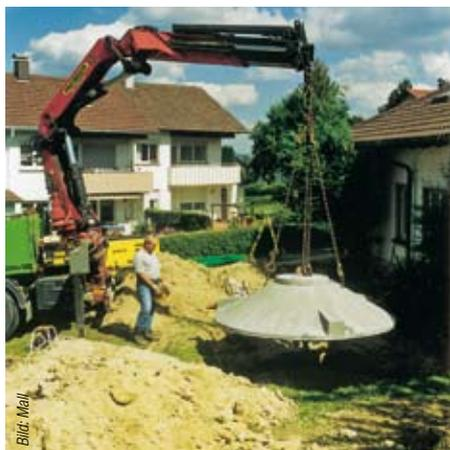
Vom Hersteller in die vorbereitete Baugrube geliefert: Betonbehälter aus einem Guss und Abdeckung als verschraubbare Betonfertigteile mit vorgefertigten Rohranschlüssen.
