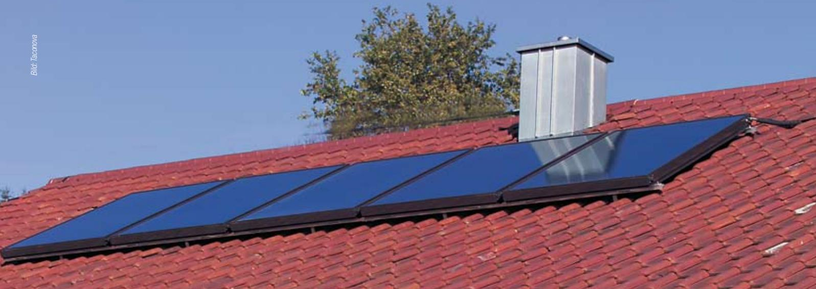
*Bei parallel geschalteten Solarkollektoren ist ein Hydraulischer Abgleich erforderlich, um eine gleichmäßige Durchströmung aller Kollektoren zu erzielen.*
