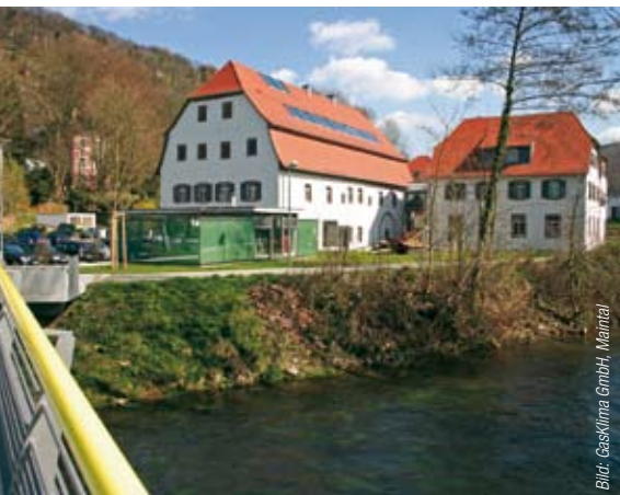
Tagungszentrum Buhlsche Mühle in Ettlingen. Im Vordergrund die Energiezentrale.
