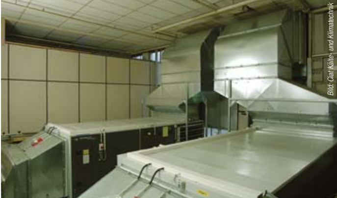
Die Demontage der alten Lüftungsgeräte forderte drei Monteure sechs Tage lang. Die neuen Zentralgeräte standen jeweils nach einem Tag auf ihrem Stahlfundament.
