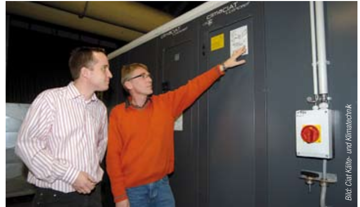
Christoph Schulte (links), Geschäftsführer von W.A. Schulte, und Dieter Otlinghaus im Schrottturm. „Früher wurden bis zu 80 000 m 3 /h warme Luft ungenutzt ins Freie abgeleitet.“
