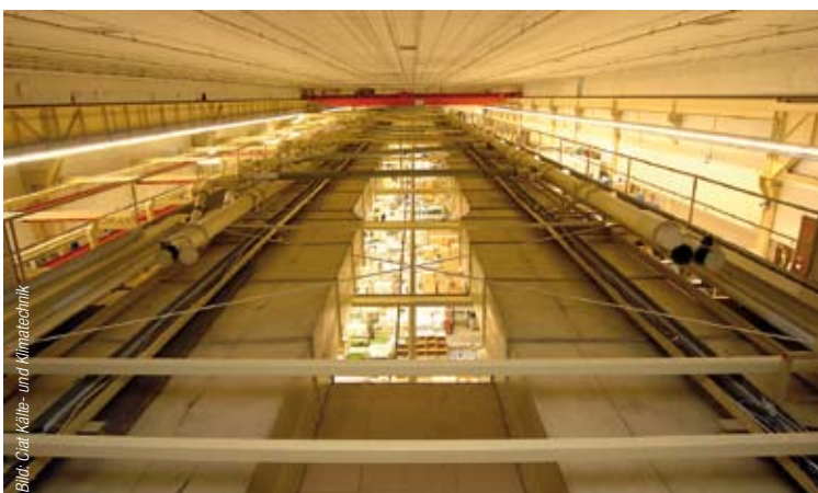
Zwei über die gesamte Länge der Halle laufende Lüftungskanäle verteilen in der 3450 m 2 großen Fertigungsstätte mit 30 Produktionsanlagen die Zuluft.
