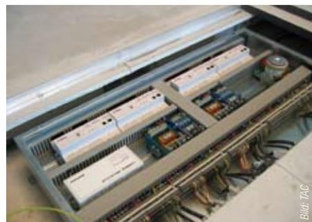
Bodenverteiler mit Controllern zur Steuerung der Raumachsen.
