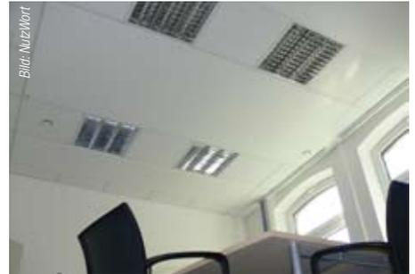
Die ersten PCM-Paneele mit Kapillarrohrsystem wurden als Kühldecke in Büroräumen bei Ilkazell installiert, hier schön zu erkennen zwischen den Leuchten.
