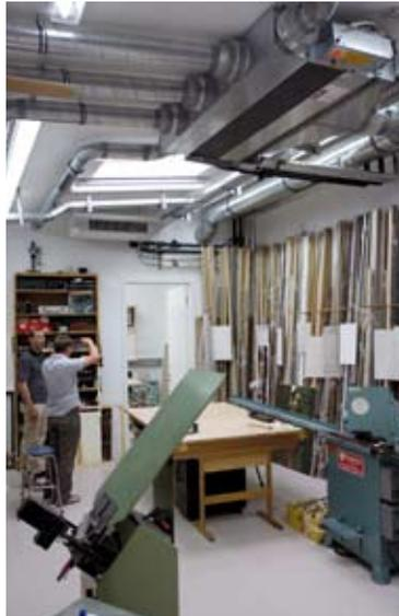
Die Kassetten-Gebläsekonvektoren und Drallauslässe der Lüftung fallen in der Decke kaum auf (linkes Bild). Der Gebläsekonvektor Top-Geko mit Außenluftanschluss wurde in der Werkstatt unter der Decke montiert (mittleres Bild). An den Bediengeräten (neben dem Monitor) geben die Galeriebesitzer die Raumtemperatur vor (rechtes Bild). Den Rest erledigt die Automatik.
