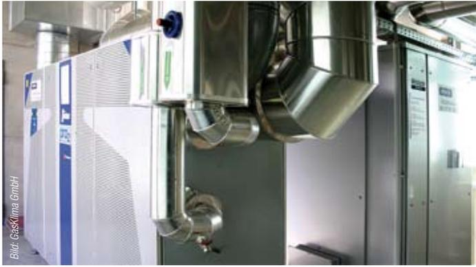
Kraft-Wärme-Kälte-Kopplung mit Mikrogasturbine Turbec NTM100 (links) und Yazaki WFC-SC 20 Absorptionskältemaschine von GasKlima (rechts).
