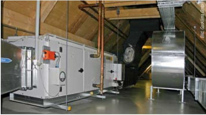
Um Schallübertragungen zu vermeiden, sind die Klimageräte am Dachstuhl aufgehängt.
