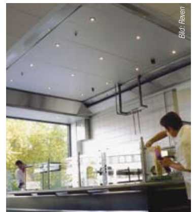
Reven: Integrierte Metall-Lüftungsdecke Revex-D mit Waschautomatik über einem Herdblock.
