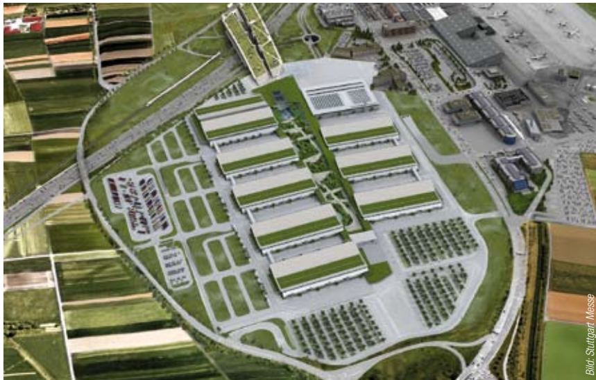
Europas modernstes Messegelände entsteht bis Herbst 2007 in Stuttgart direkt neben dem Flughafen.
