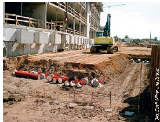
Prinzip des Erdwärmeübertragers. Sammelrohr und Bauwerksanschluss. Ausführung des Erdwärmeübertragers mit 88 Kanälen aus Polypropylen. Ansaugturm. Lüftungskonzept im Gebäude. Die Anlage gehört zu den weltweit größten Luft-Erdwärmeübertragern.
