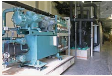
Redundant aufgebaute Kältemaschine mit Q_0 = 2 \times 129 \text{ kW} . Nach der Modernisierung wird der Kaltwasservorlauf, abhängig vom Entfeuchtungsbedarf, gleitend zwischen 6 und 12^\circ\text{C} gefahren.
