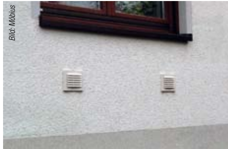
Bild 5 Ansicht der Ansaug- und Fortluftöffnung an der Außenwand.
