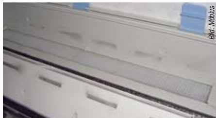
Bild 10 Geöffnetes ClimaRad mit Ansicht der Filter.
