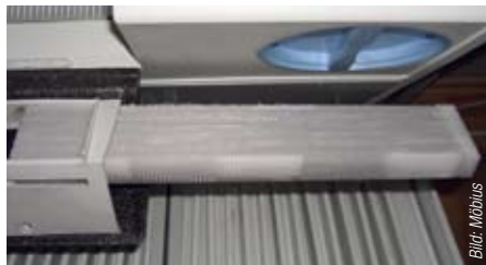
Bild 11 Herausziehen des Filters.
