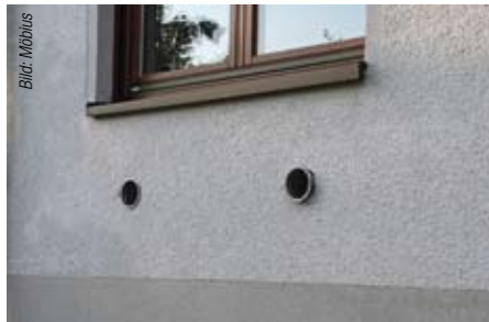
Bild 6 Kernbohrungen (Durchmesser: 110 mm) in der Außenwand.
